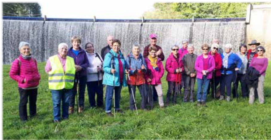
Sortie à St Antoine près du barrage de Kerné Uhel à Lanrivain.
