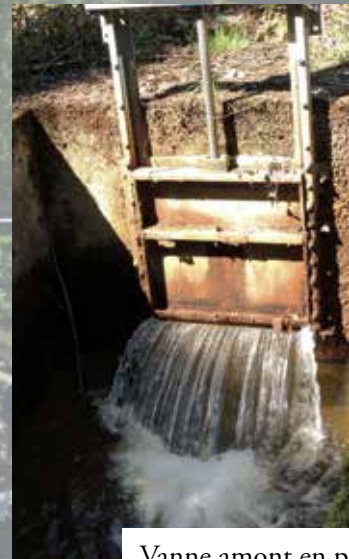
Vanne amont en pied de digue
