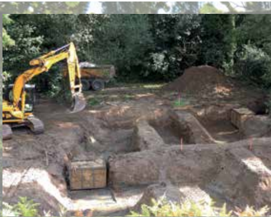
Mise en place des bassins de décantation
