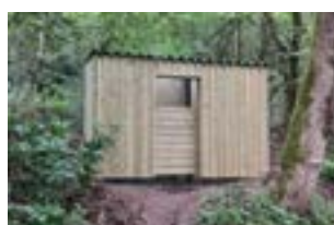
Réfection extérieure des toilettes de l'étang.
