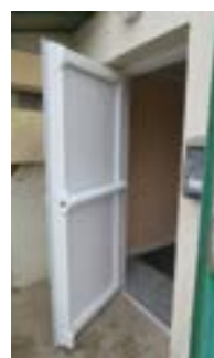
Remplacement de la porte du local des Restos du Cœur.
