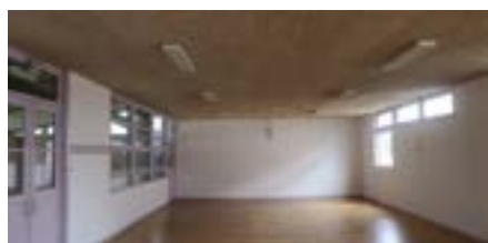
Restauration intérieure de la 2eme partie de la salle de Kerbuannec
